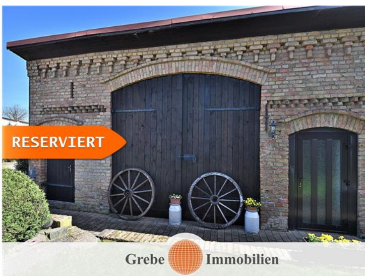
Das Tor zur Scheune
